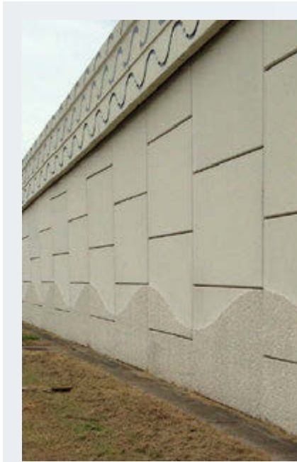
Patrón ondulado en muro de retención I-45 Sur.
