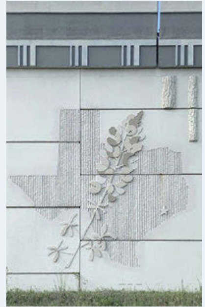
Muro de retención con Aciano de Texas.
