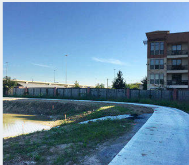
Ejemplo de un sendero a lo largo del estanque de detención adyacente a US 290.
