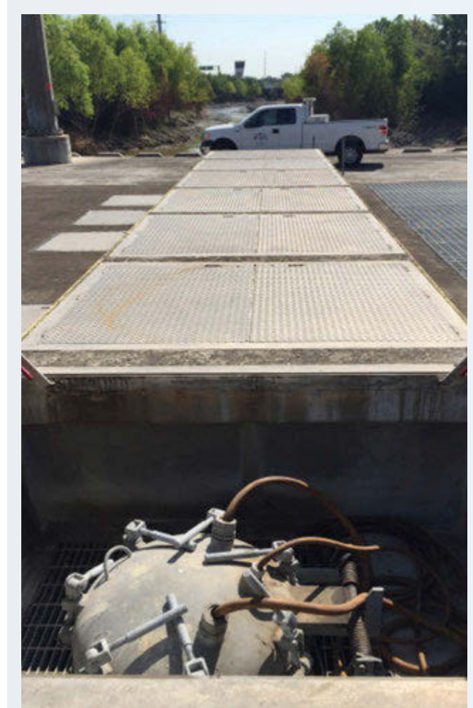
Cubierta de la Bomba de Descarga con Vistas de la Detención
