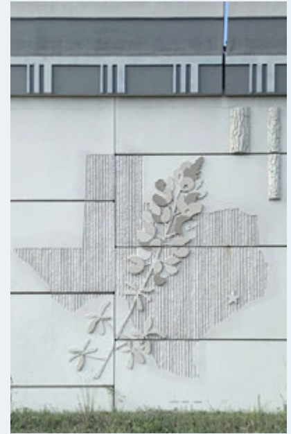
Muro de retención con Aciano de Texas.
