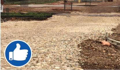
Salida de construcción correctamente instalada usando material triturado. El material está en buenas condiciones de mantenimiento.
