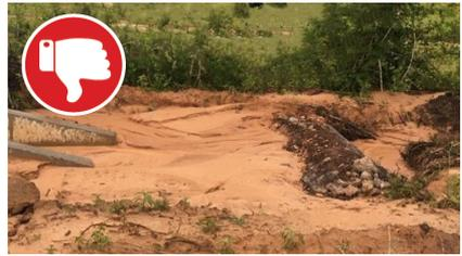
BMP fallida: la represa se llena hasta el tope de su capacidad y necesita mantenimiento. La represa de control debe cubrir todo el largo del drenaje. Se deben quitar los residuos y limo de la represa en forma periódica.
