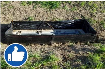
Protección de drenaje pluvial correctamente instalada: la tela correctamente colocada, las estacas aseguradas, correcta superposición del material.
