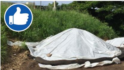
Reservas correctamente gestionadas: la pila está cubierta y asegurada.
