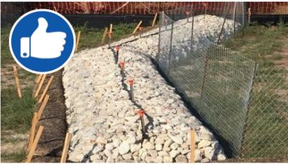
Represa de control correctamente instalada, usando una represa de filtro de rocas.
