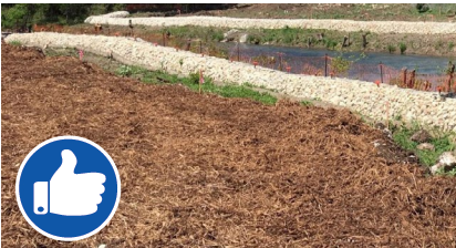
Mantillo correctamente colocado: capa uniforme con profundidad correcta.
