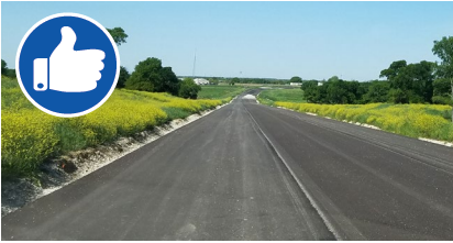
Vegetación correctamente instalada – sistema de raíces bien instalado.
