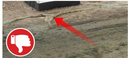
BMP fallida: la manta de malla comenzó a degradarse y se despega del suelo. Reemplazar o volver a colocar las mantas de malla flojas.
