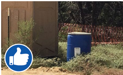
El baño portátil debe estar anclado de manera correcta en un lugar seguro y plano, lejos de los desagües y drenajes.
