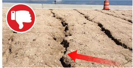
BMP fallida: el agua pluvial causa la formación de sumideros, porque las medidas de estabilización de la vegetación no se implementaron correctamente. Estabilizar con matriz de fibra unida o mantas de control de erosión
