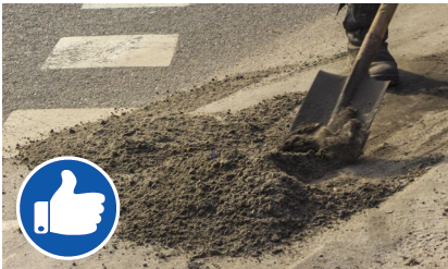
Remover sedimentos de la carretera.
