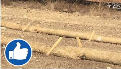
Biorrollos correctamente instalados: estacas aseguradas y leños superpuestos.
