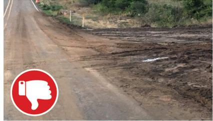
BMP fallida: la salida de construcción estabilizada no se instaló antes de permitir a los vehículos salir de la zona en este lugar, lo que provocó rastros de vehículos fuera del sitio.
