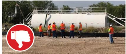
Las BMP no abordan contaminantes potenciales del tanque de lodo; se necesita contención secundaria. La valla de limo es para sedimentos y no protege contra el lodo que pueda filtrarse del tanque. Todo derrame del tanque de lodo deberá abordarse, y el tanque se debe ubicar lejos de las vías navegables.
