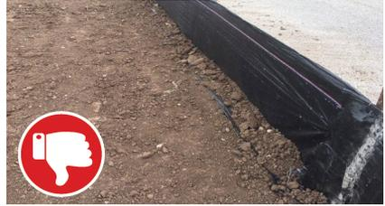
BMP fallida: el tejido debe estar a una profundidad de seis pulgadas del suelo. Se usará malla de alambre para reforzar la valla de limo con los postes de metal. Remover los sedimentos antes de que lleguen a la mitad de la altura de la valla.
