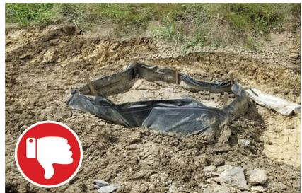
BMP fallida: el dispositivo de drenaje pluvial no tiene el mantenimiento correcto. Está lleno de sedimentos y colapsando.
