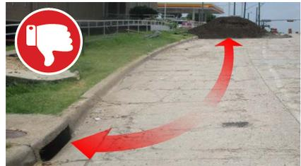
La pila está incorrectamente colocada y no hay gestión; hay riesgo de descarga de sedimentos en la entrada. Debe colocarse una cubierta sobre la reserva y asegurarse. Use BMP secundarias para evitar la descarga de sedimentos en la entrada.
