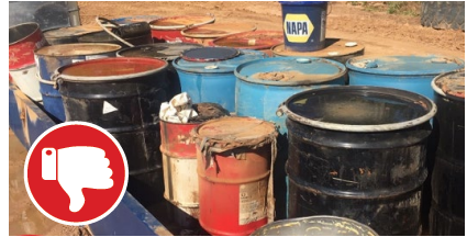
Los tambores necesitan tapas y etiquetas. El almacenamiento de materiales peligrosos debe ser en interiores o en un área cubierta. Los materiales peligrosos guardados en el sitio deben ser los mínimos.
