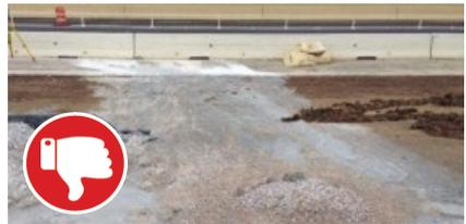
El área de lavado no tiene contención adecuada y provocó el lavado hacia la carretera. Colocar letreros que indiquen claramente el lugar del lavado. Se deben mantener y gestionar BMP en el área circundante, y también se deben implementar BMP para evitar rastros fuera del sitio y escorrentías.
