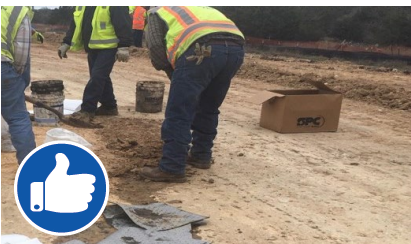
Implementación correcta de métodos de limpieza en seco usando absorbentes.
