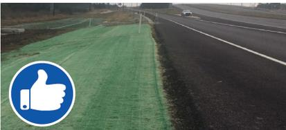
Capas correctamente instaladas: instaladas por debajo del borde del pavimento y que cubren toda el área.
