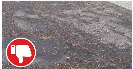
BMP fallida: el mantillo en general no es apropiado en áreas de flujo concentrado. El mantillo debe aplicarse regularmente en áreas de alto tránsito y se debe aplicar de manera uniforme y pareja y con el espesor apropiado.
