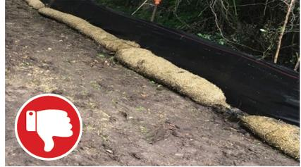
BMP fallida: el biorrollo ineficaz debe estar superpuesto y anclado. Asegúrese de que el diámetro del tubo y la incrustación en el suelo cumplan con el tamaño especificado en los planos.
