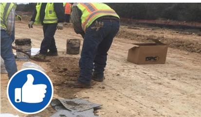
Implementación correcta de métodos de limpieza en seco usando absorbentes.
