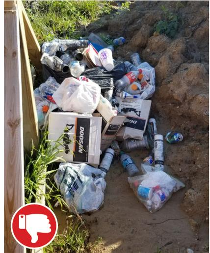
Se debe brindar educación sobre el uso correcto y los cubos de desecho. Debe colocarse la cantidad adecuada de cubos de residuos en toda la zona de construcción. Los cubos de residuos deben vaciarse periódicamente.
