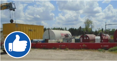
Uso correcto de contención secundaria.
