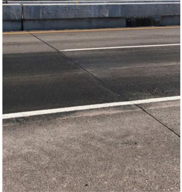
Figure 3-5: Example of a hot pour joint seal.
